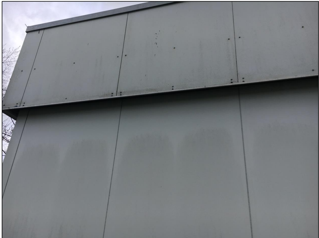
Abb. 12: Bau 68 Tiefe Traufkante, Holz hinter Verkleidung, gesamtes Gebäude
