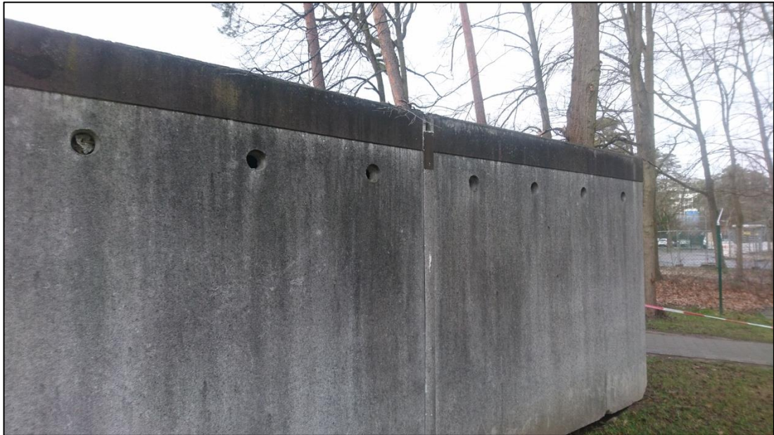
Abb. 7: Bau 18-1 Garagengebäude mit röhrenförmigen Zugängen in der Wand
