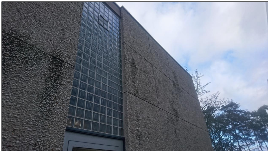
Abb. 8: Bau 18 Gebäudeaußenwand mit Waschbeton verkleidet, Traufkante 4 m breit
